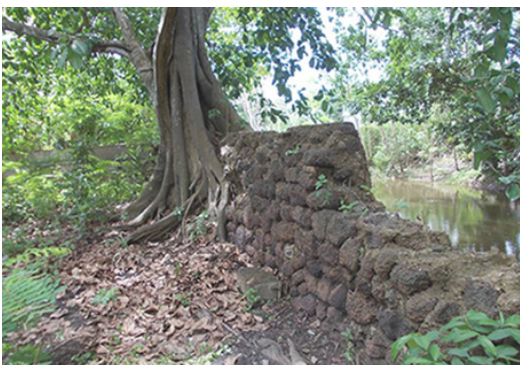
Cimientos de mocorrero que sustentaron la vivienda de Claudio Conde Cid
