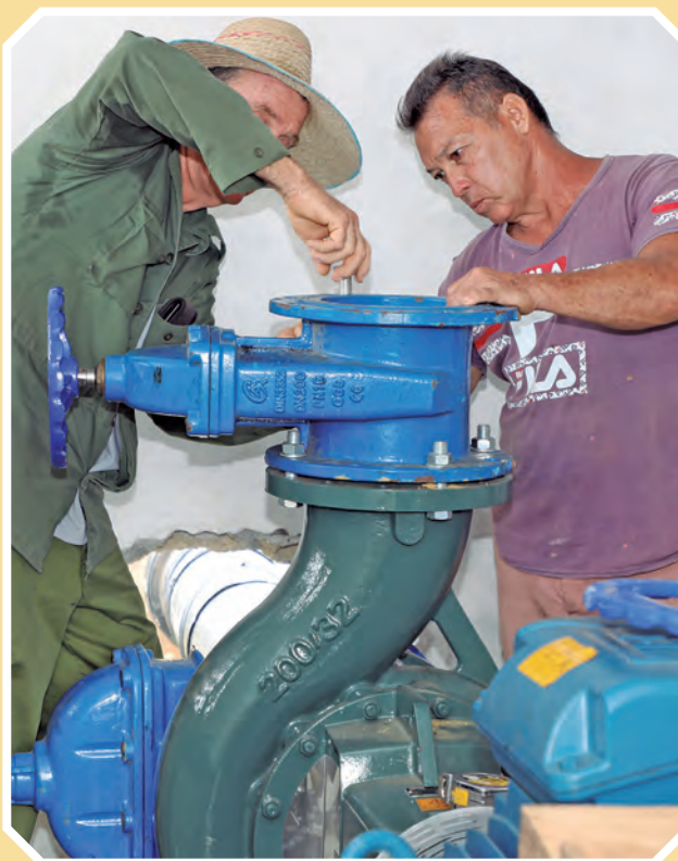
Ultiman detalles en el montaje de las bombas
