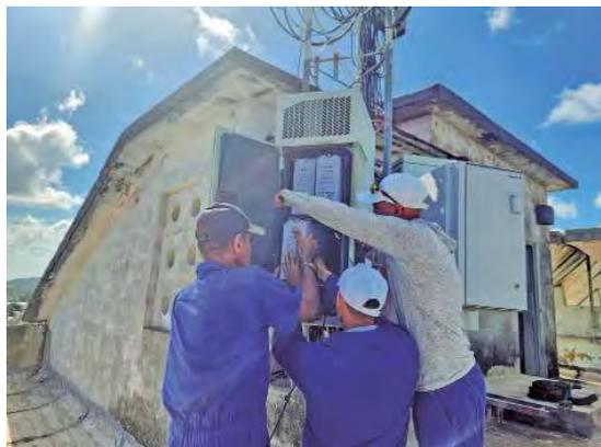
para mantener activas las radiobases en caso de fallas o cortes de energía frecuentes en esta época del año de
