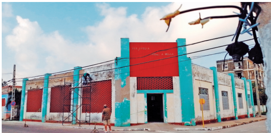
Los trabajos en la Julio Antonio Mella iniciaron en febrero
