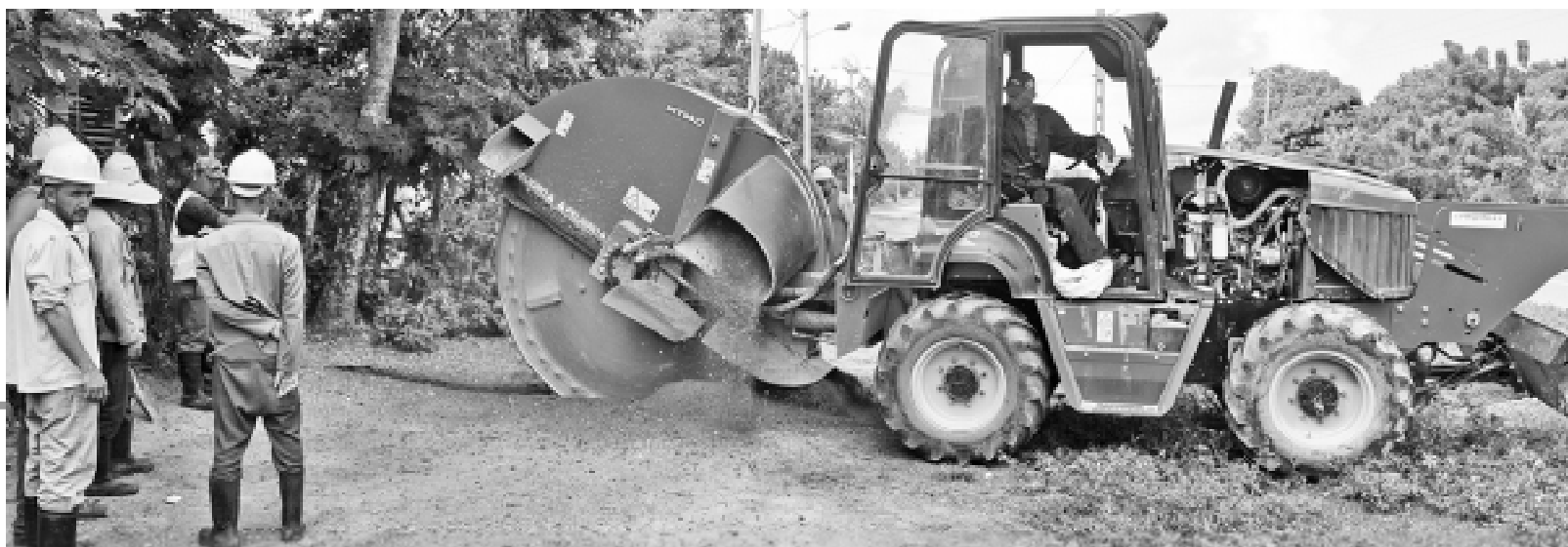
La brigada de Las Tunas con la zanjeadora avanza en las redes
