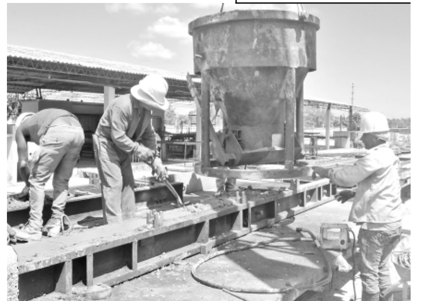
Hormigonando piezas de la cerca perimetral
